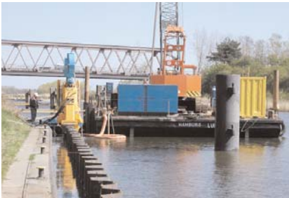
Uferspundwand im oberen Vorhafen
