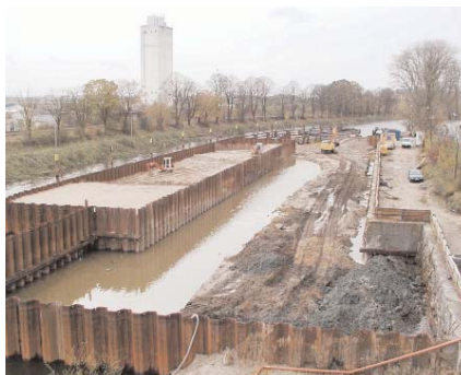
Aushub der Baugrube mit Schlitzwand (re.) und Kastenfangedamm (li.)
