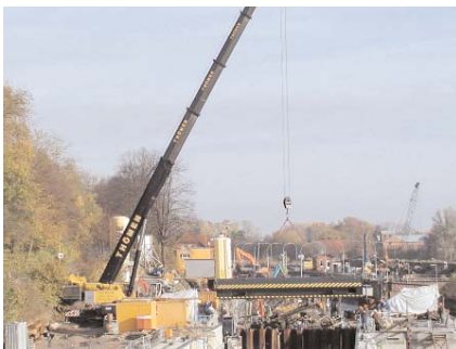
Drucksegmenttor wird eingebaut
